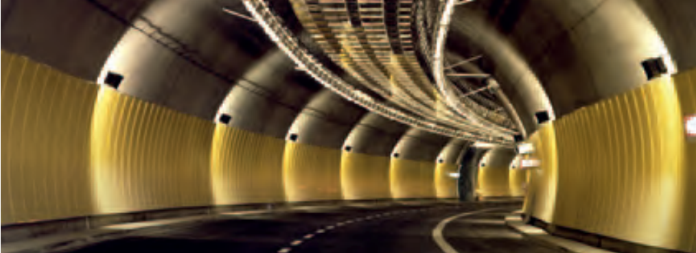
Powlekana stal nierdzewna jest stosowana na odporne na korozję okładziny tuneli w celu uniknięcia odbłasków światła od powierzchni. Zdjęcie: ThyssenKrupp Acciai Speciali Terni, Terni (Włochy)
