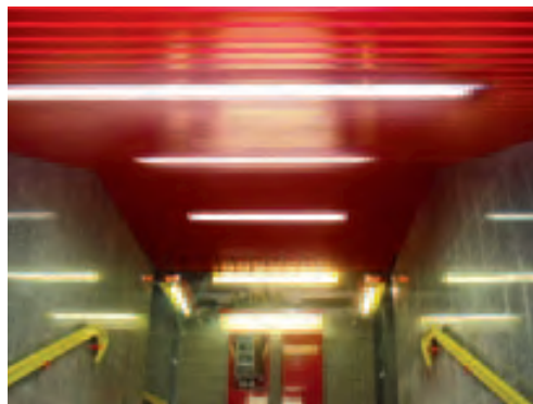
Atrakcyjne, barwione na czerwono wykończenie na stali nierdzewnej na stacji metra Piazzale Carlo Maciachini w Mediolanie.
