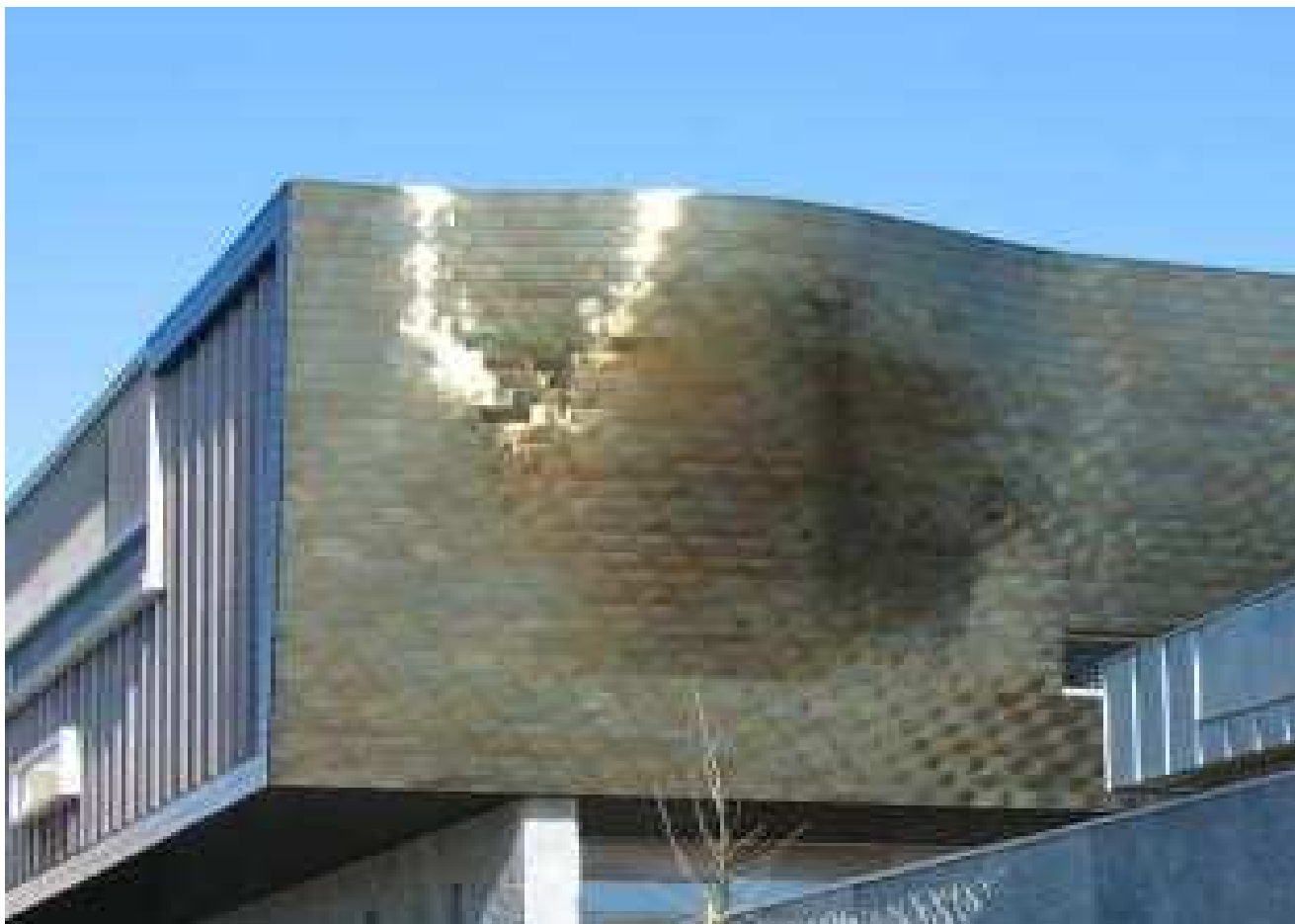
Collège Albert Debeyre, Beuvry - France Parallèle 3 architectes © ArcelorMittal
