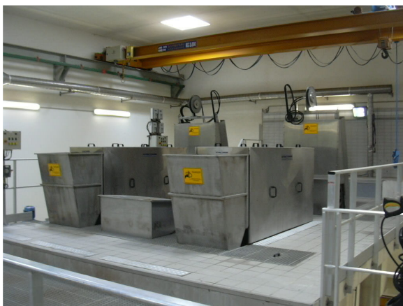
Oczyszczanie mechaniczne wewnątrz
