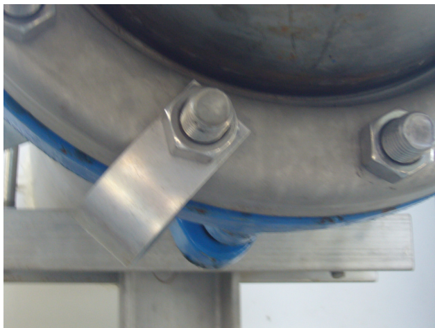
Rys. 4. Anoda protektorowa z aluminium ogranicza ryzyko wystąpienia ogniwa galwanicznego między stalą nierdzewną i żeliwem
