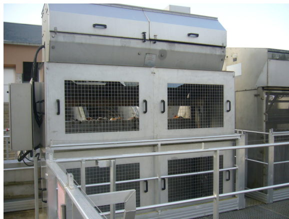
Oczyszczanie mechaniczne z zewnątrz
