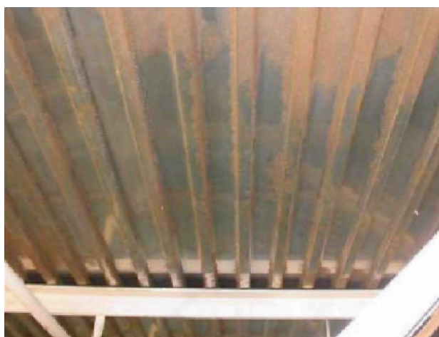
Rys. 2. Pokrycie dachu nad pływalnią wykonane ze stali 304 [4].
