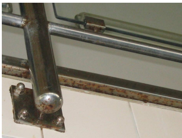
Rys. 3. Skorodowane elementy balustrady w budynku pływalni.
