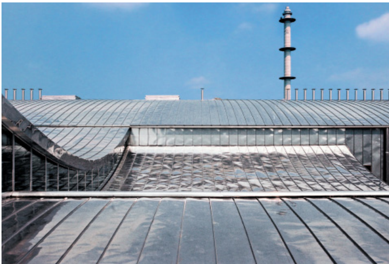
Fot: Jean-Luc Deru, DAYLIGHT s.p.r.l., Liège
