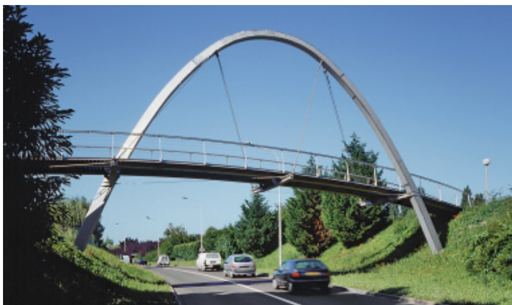
Zakrzywiony pomost znajdujący się pod łukiem ze stali nierdzewnej.
