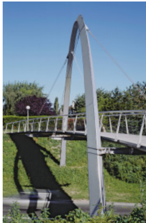
Łuk o przekroju trójkątnym zwęża się od fundamentu do samego wierzchołka.
