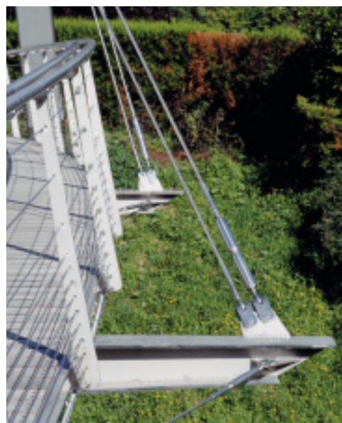
Sparowane wsporniki łączą belki poprzeczne z łukiem.
