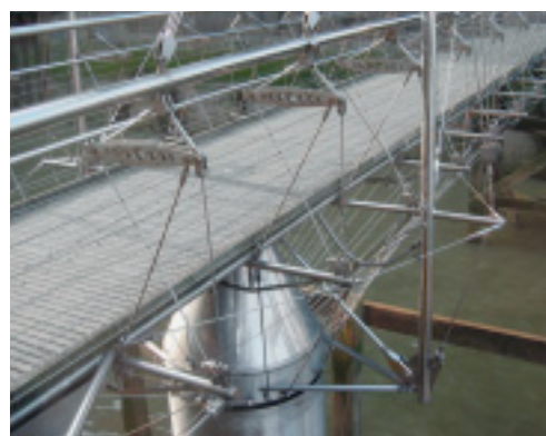
Układ cięgien ułożonych w kształt wachlarza podtrzymuje obrotową kładkę dla pieszych.
