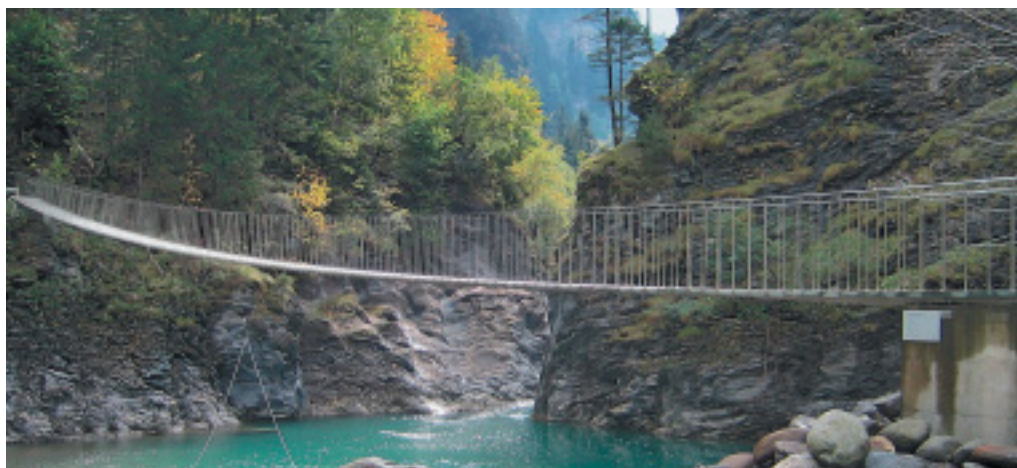
Cztery cienkie liny nośne ze stali nierdzewnej i chodnik z naturalnych płyt kamiennych łączą szlak nad 40 metrowym wąwozem.
