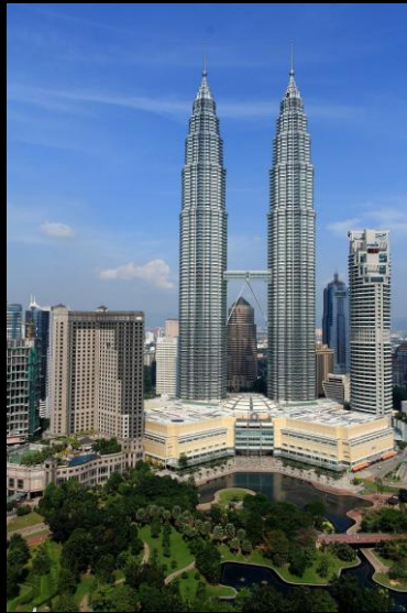
Petronas Towers, Kuala Lumpur 1997r. ; 452m wysokości Do budowy użyto ok. 55 tys. ton stali nierdzewnej – jedno z największych skupisk stali nierdzewnej w jednym miejscu.
