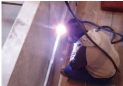
Spawanie montażowe elementów basenu pływakiego wykonanych ze stali nierdzewnej
