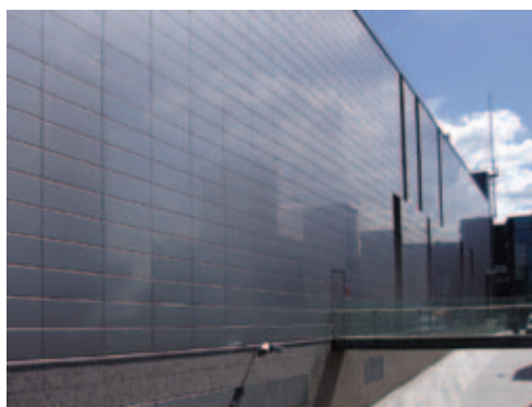
Zastosowanie stali nierdzewnej pochodzącej z jednej partii materiału i jednego dostawcy zapewnia spójny wygląd powierzchni.
