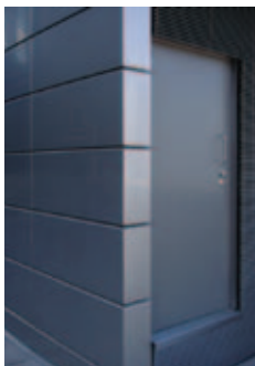
Efekt usztywnienia krawędzi zapewnia optyczną płaskość powierzchni
