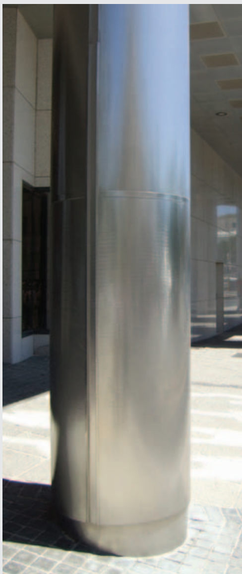
Kształtowane elementy ze stali nierdzewnej wydajnie maskują wgniecenia oraz zapewniają regularny wygląd powierzchni
