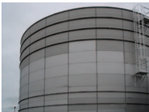
Połączenie blach pochodzących z różnych partii materiału może prowadzić do nieprawidłowego wyglądu zewnętrznego
