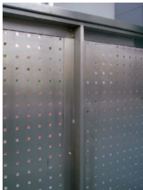
Miejscowe nacieki korozyjne zostały spowodowane przez zanieczyszczenia cząstkami metalicznymi od tarczy szlifierskiej, którą wcześniej obrabiano stal węglową (po lewej). Występujące zanieczyszczenia cząstkami żelaza można usunąć w procesie trawienia bezpośrednio na placu budowy (po prawej) [12].
