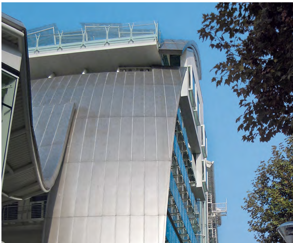
Opady deszczu w naturalny sposób czyszczą odślonięte elementy elewacji budynku. Zdjęcie: Centro Inox, Mediolan (I)
