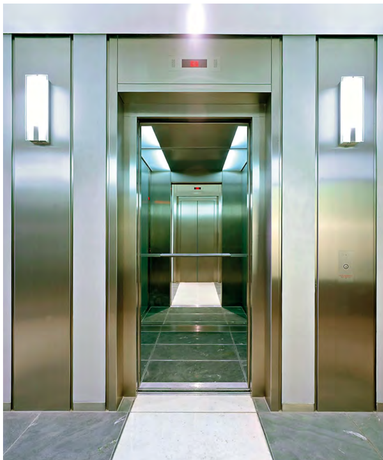
Ferrytyczny gatunek stali nierdzewnej 1.4016 z nawalcowanym wykończeniem przypominającym klasyczne wykończenie satynowe. Zdjęcie: ThyssenKrupp Nirosta, Krefeld (D)
