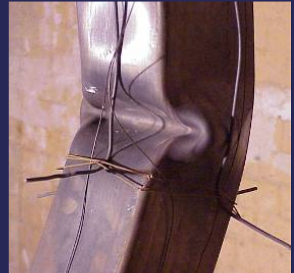
Lokalne wyboczenie kolumny
