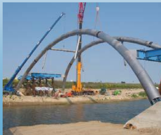
Pieve di Sacco Bridge, Padua; (1.4362) duplex stainless steel
