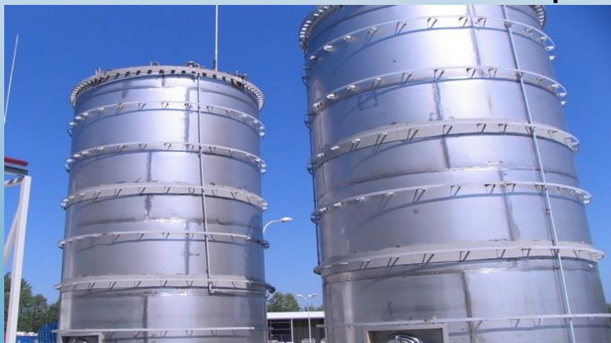
Zbiorniki na wodę.
